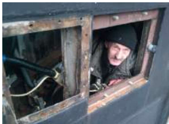
Рисунок 12 – Слесарь-сборщик В. Н. Павлов проверяет кабельный ввод у ниш для установки бортовых приборов 1М1 и 1М2/3
