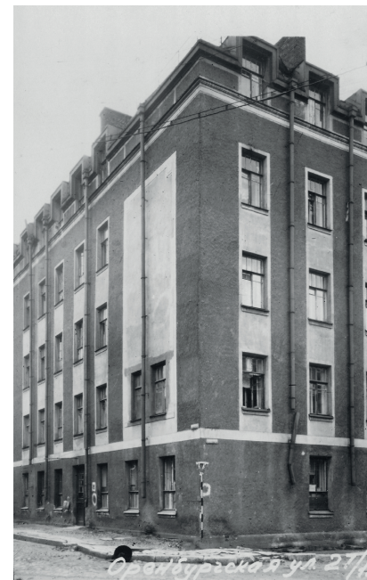
Рисунок 6 – Вид углового фасада дома № 27/12 по Оренбургской улице [9]
